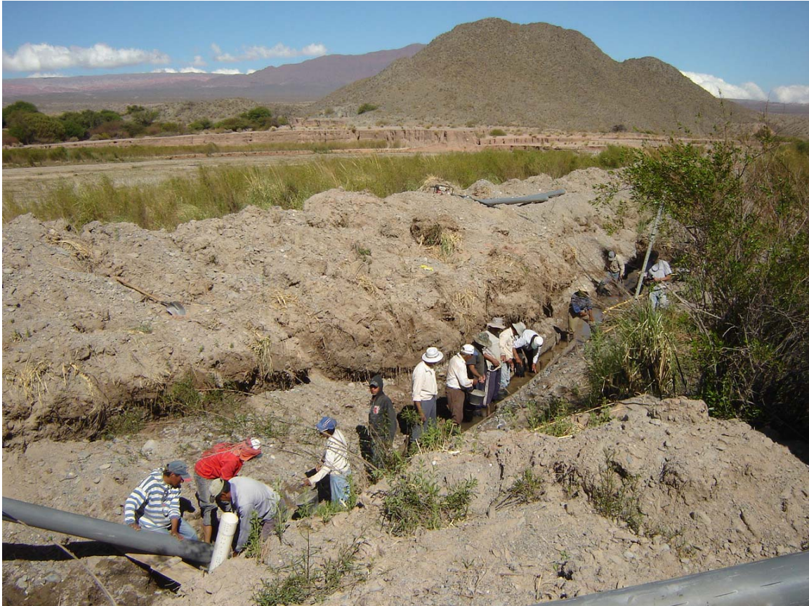
Fotografía N° 3: Trabajo comunitario para la construcción de la obra de agua en el Churcal. Año 2008. Fuente: Equipo Técnico Seclantás.
