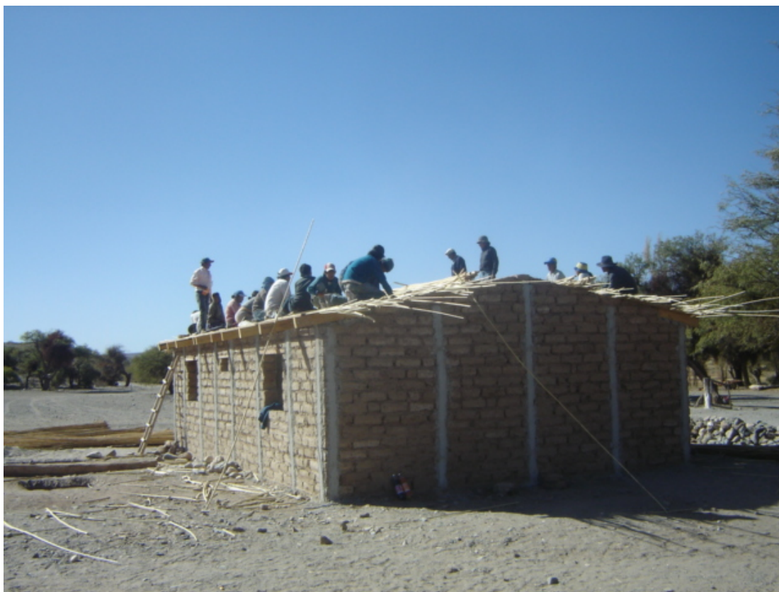
Fotografía N° 2: Trabajo comunitario para la construcción del puesto sanitario en el Churcal. Año 2008. Fuente: Equipo Técnico Seclantás.
